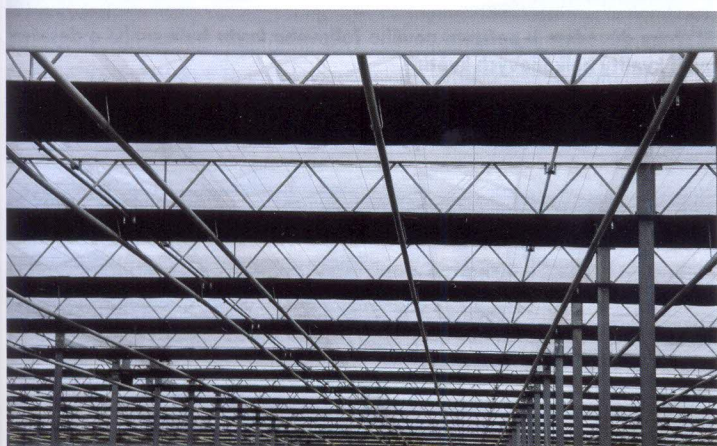
Součástí skleníku jsou zatemňovací, stínící a termoizolační clony
